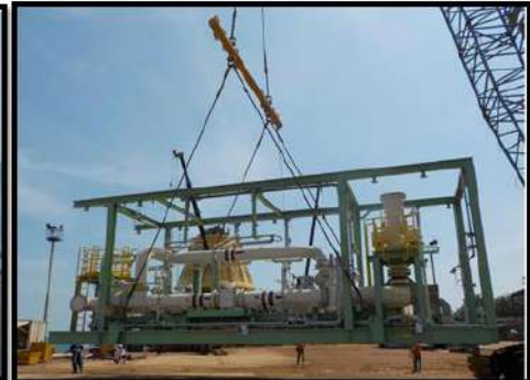
LIFTING OF SKID - ACTUAL
